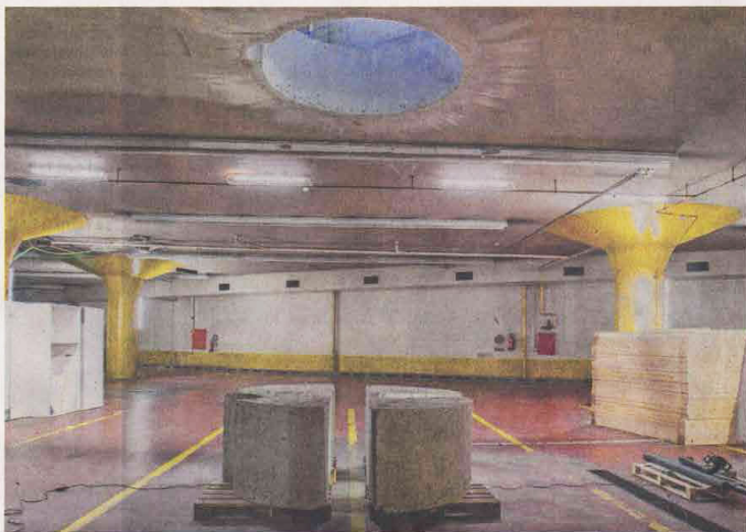
«Bivouac» permet aux visiteurs de découvrir ces souterrains datant des années 1960. Au centre, la découpe de la dalle principale du bâtiment de la Rasude – 95 cm de béton! VANESSA CARDOSO
